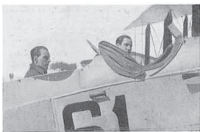
Las dos posiciones de la capota en un aparato equipado para vuelos sin visibilidad
